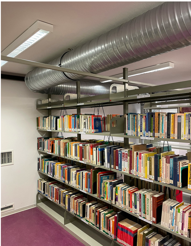
Neue Lüftungsrohre zieren Bücherregale im Magazin
