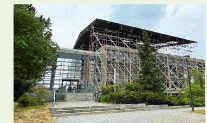
Im Rahmen der energetischen Sanierung an der EHB hat der Audimax im F-Gebäude der EHB aktuell ein Schutzdach. Der Aufbau ist notwendig, um den denkmalgeschützten Saal vor witterungsbedingten Zerstörung zu sichern. Er erhält dann ein neues Dach und eine neue Unterdecke mit Brandschutz, Licht- und Lüftungstechnik – denkmalgeschützig und nach neuestem Standard.
